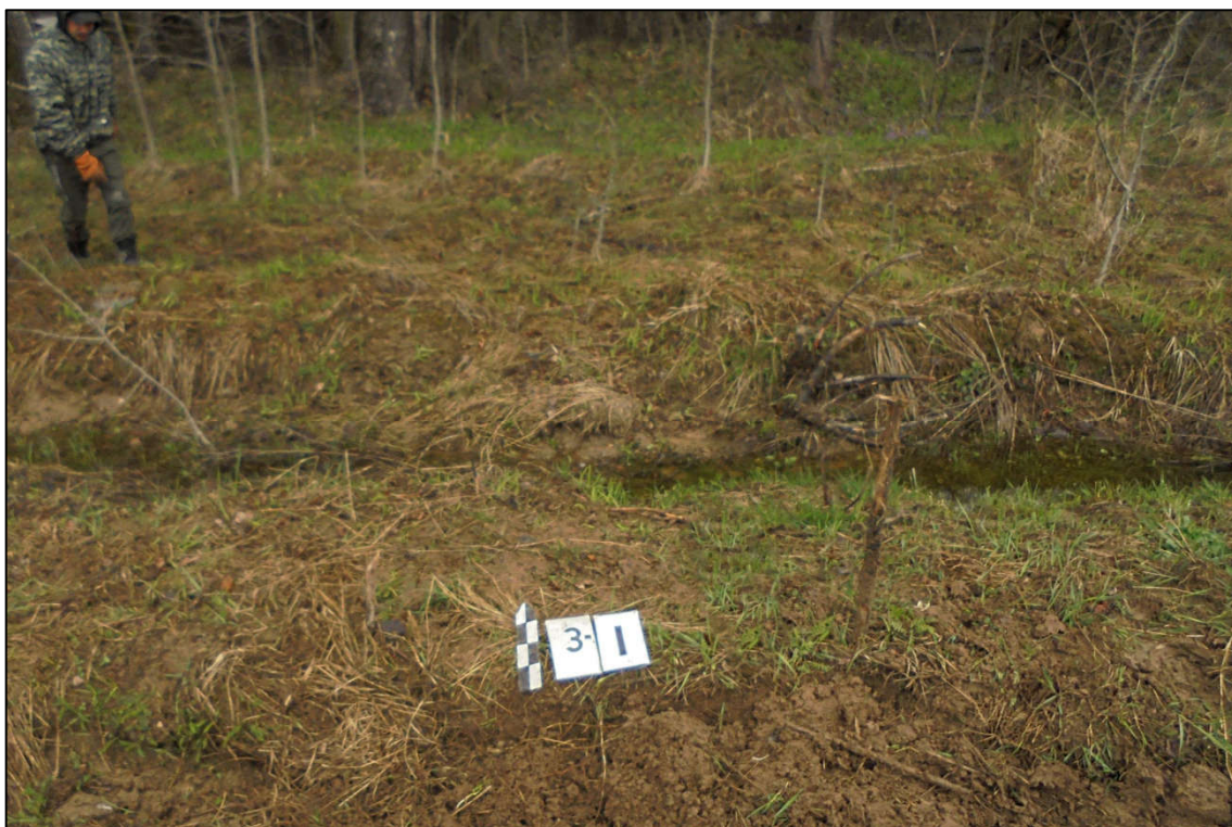
Рис.146. Зачистка №1. Рекультивация. Вид с юга.
