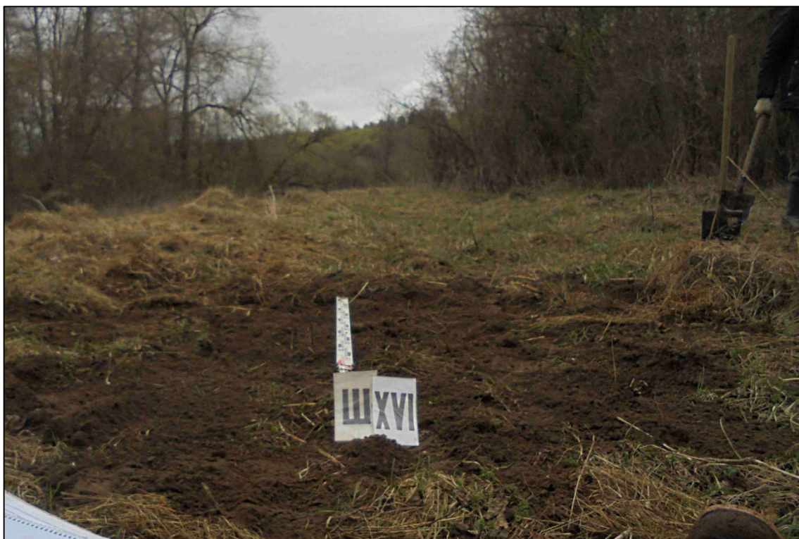
Рис.142. Шурф №16. Рекультивация. Вид с юга.
