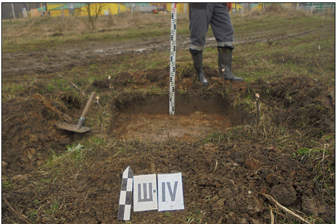
Рис.79. Шурф №4. Откопанный. Вид с юга.
