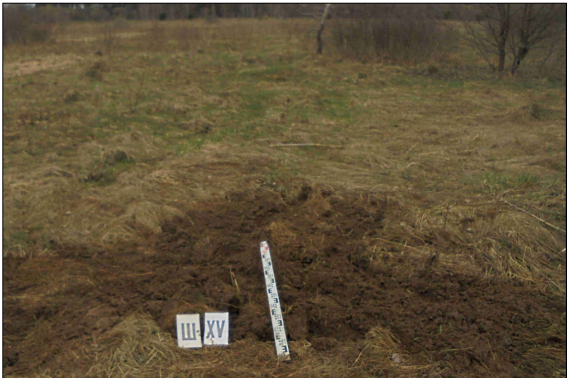
Рис.137. Шурф №15. Рекультивация. Вид с юга.
